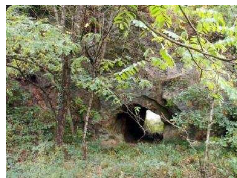
Ancien tunnel ayant servi à l'exploitation minière.
